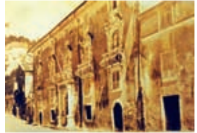
Le palais Comuto à Zante entièrement détruit par le tremblement de terre de 1953
